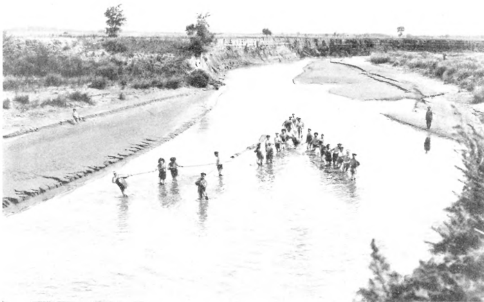
На р. Даляохъ. Сплавъ лѣса на постройку мостовъ.
