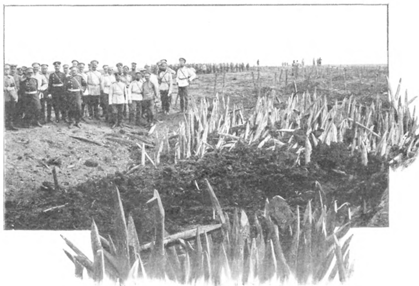
Загражденіе изъ кольевъ, частью разрушенное взрывомъ динамитныхъ патроновъ. Вдали проволочныя загражденія. Группа съ ген. Линевицемъ.
