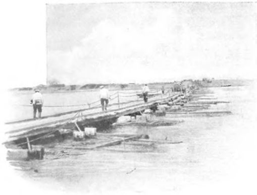
Устройство периль на мосту.
