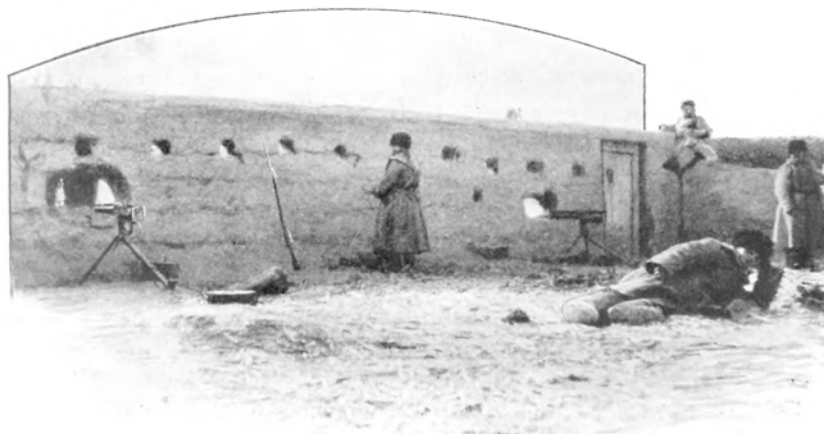
Стѣнка съ двумя выючными пулеметами, приспособленными къ оборонѣ. Позиція у деревни Чжанжуанцзы.
